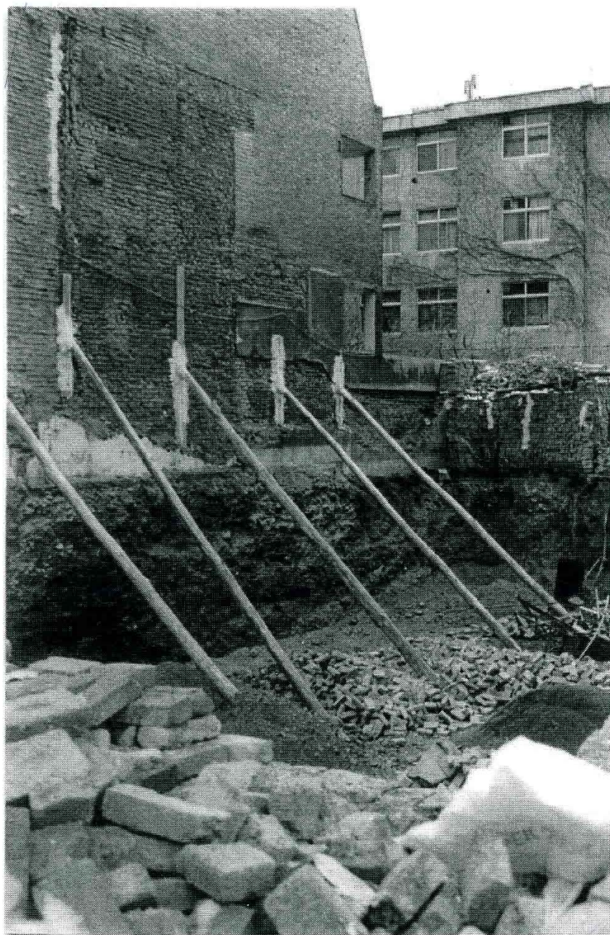
شکل (2) نمونه‌ای از تیرک‌های مایل چوبی جهت نگهداری ساختمان همسایه حین گودبرداری
