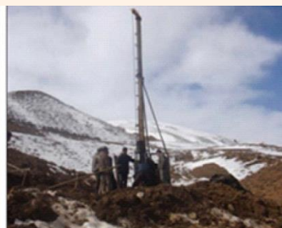
حفاری گمانه عمیق در مسیر تونل در مناطق سرد
