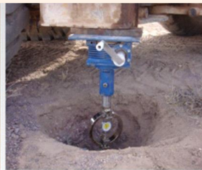
انجام آزمایش CBR در محل پروژه
