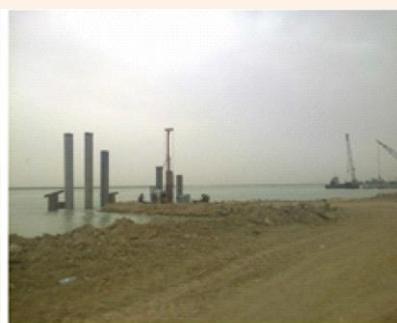
عملیات حفاری جهت آزمایش شمع
