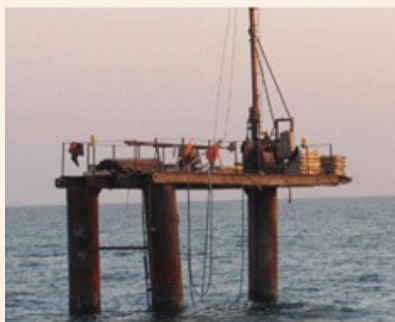
عملیات حفاری در دریا بر روی سکوی ثابت
