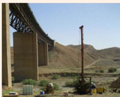
عملیات حفاری در مسیر خط آهن
