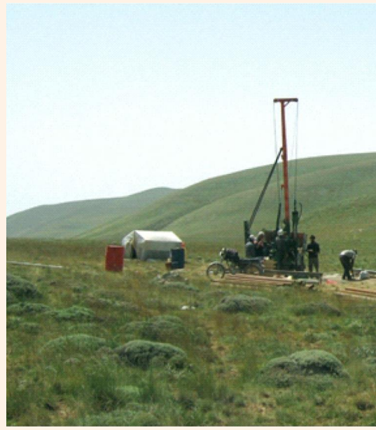
حفاری اکتشافی مسیر تونل انتقال آب در غرب کشور
