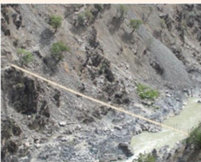
ساخت پل معلق جهت دسترسی به جناحین ساختگاه
